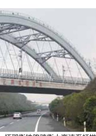
怀邵衡铁路跨衡大高速系杆拱
